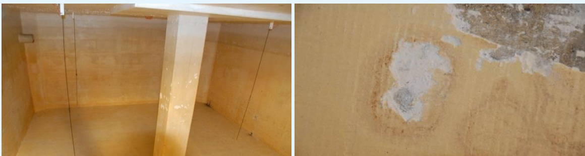
Abb. 5: Fallbeispiel: Innenbeschichtung im Reservoir der oberen Druckzone.
